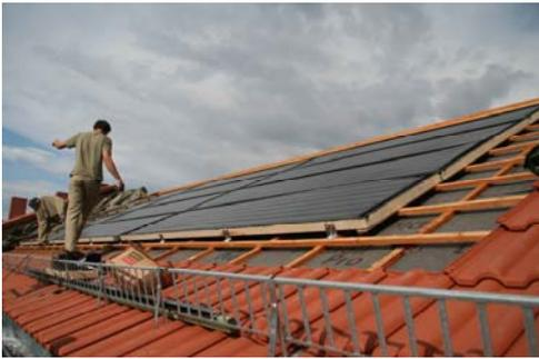
Abb. 4: Integrierte Solaranlage
