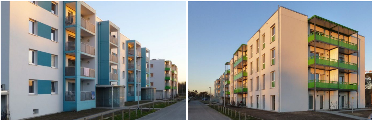
Abb. 0.1: Straßenansichten des modernisierten Gebäudes (links) und des Ersatzneubaus (rechts)
